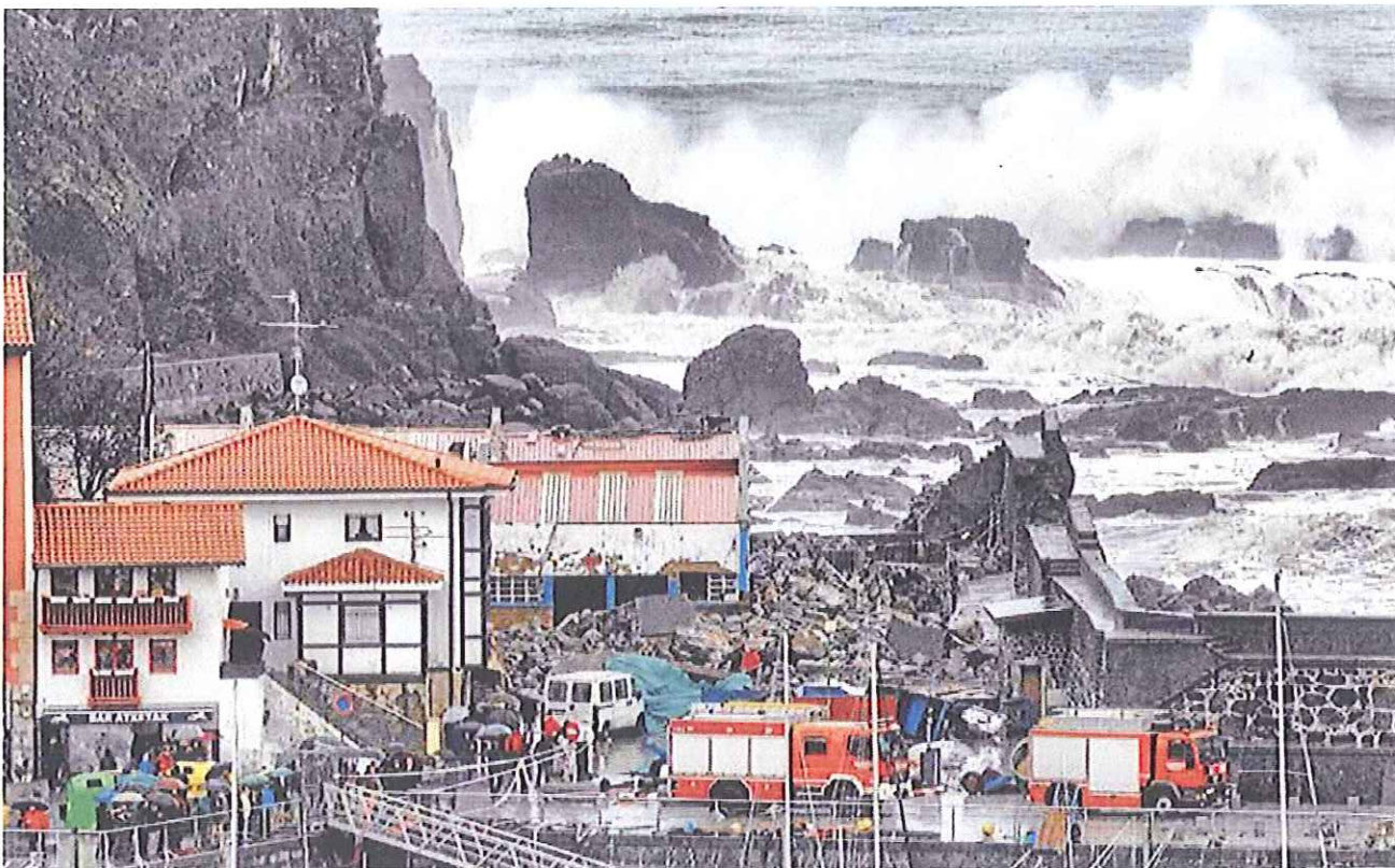
La rotura del espigón de Frantxua dejó sin protección a las lonjas, que sufrieron el embate de las olas y facilitó la llegada del agua hasta el puerto interior. FOTO: ZIGOR ALKORTA
